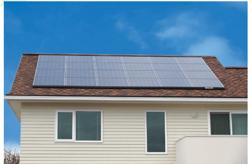
このモデルハウスに搭載されている太陽光パネルは、シミュレーションすると年間3.67kwh=年間約105,744円分の発電を行います
